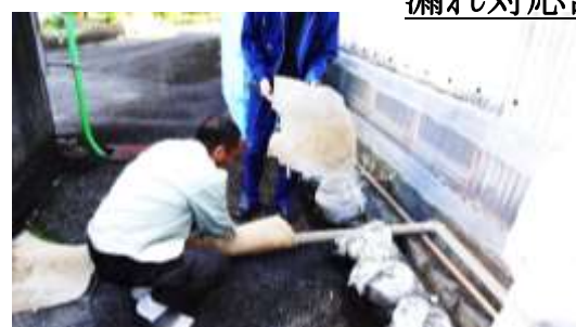
漏れ対応訓練
